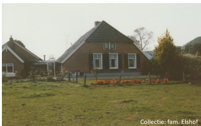
Figuur 1: voor aanvang verbouwing
