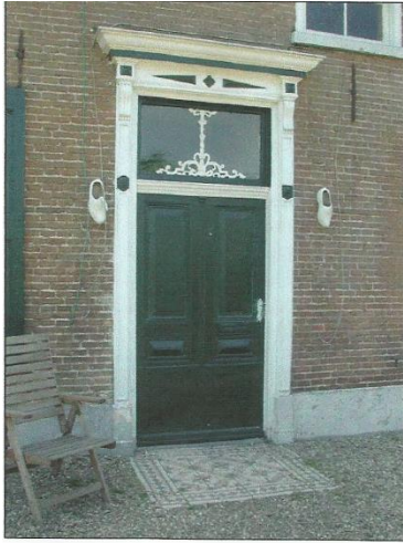
Voordeur met karakteristieke omlijsting.
